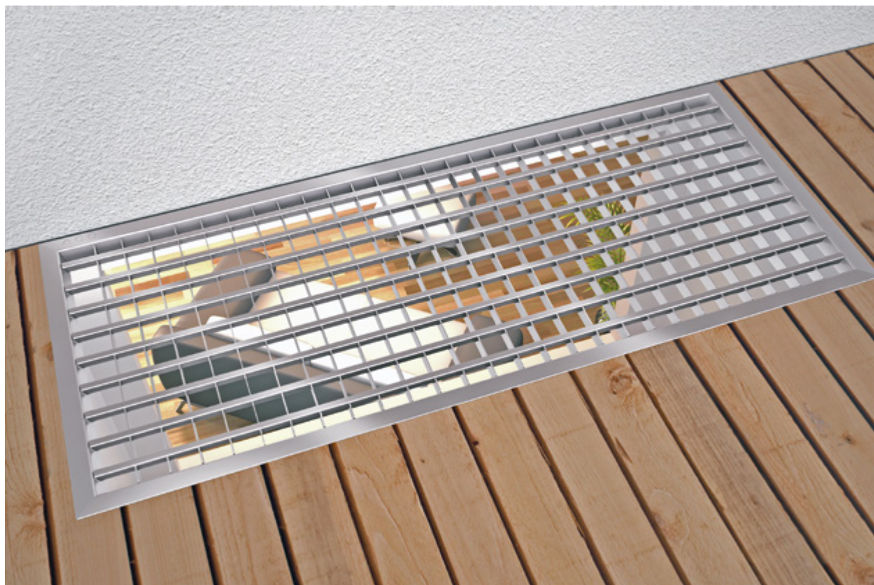
Lichtschacht mit eingelegtem Längsprofil-Design-Rost
