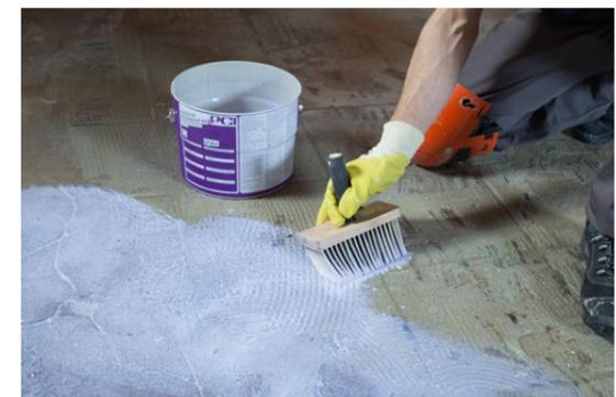
PCI Gisogrund 404 in der Kontrollfarbe Violett ermöglicht eine hohe Verbundhaftfestigkeit von Ausgleichsmassen und Verlegewerkstoffen zum jeweiligen Untergrund.
