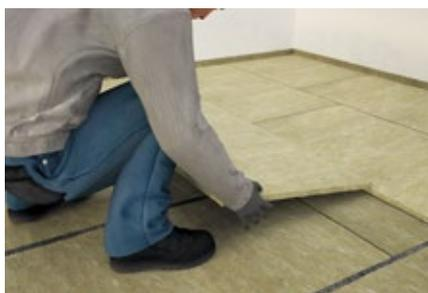
Gleichen Sie nun die Unebenheiten der Rohrdurchführungen mit Knauf Bituperl aus, und verlegen Sie anschließend die Knauf Insulation Trittschall-Dämmplatten versetzt im Plattenverband.
