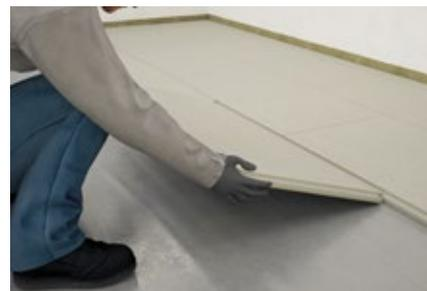
Verlegen Sie abschließend die Fertigteil-estrich-Elemente (z. B. Knauf Brio 23) nach Anweisung des Herstellers.
