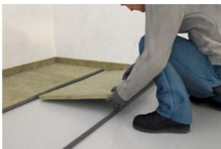
Verlegen Sie zunächst den Knauf Insulation Randstreifen. Anschließend legen Sie die Knauf Insulation Dämmplatten als Höhenausgleich ein.
