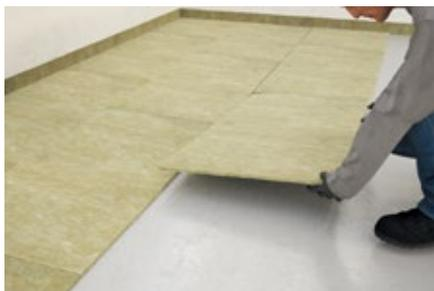
Verlegen Sie zunächst den Knauf Insulation Randstreifen. Anschließend verlegen Sie die Knauf Insulation Trittschall-/Wärmedämmplatten im Plattenverband.
