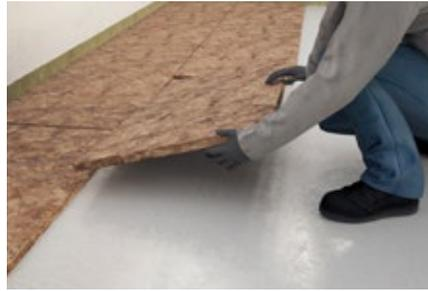
Anschließend verlegen Sie die Knauf Insulation Trittschall-/Wärmedämmplatten im Plattenverband.
