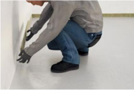
Verlegen Sie zunächst den Knauf Insulation Randstreifen.
