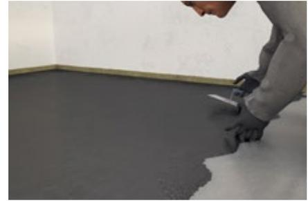
Verlegen Sie die Abdeckung und bauen Sie abschließend den Gussasphalt-Estrich ein.
