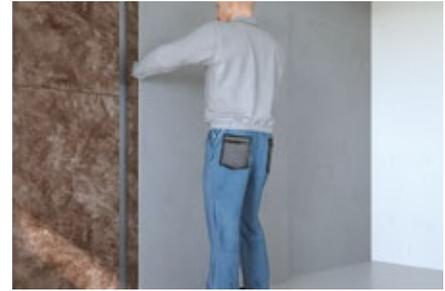
Anschließend wird die andere Seite mit Hartgipsplatten, z. B. Knauf Diamant, gemäß Herstellerangaben beplankt.
