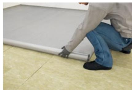
Breiten Sie schließlich die PE-Folie über die Trittschall-Dämmplatte aus und installieren Sie die Fußbodenheizung und den Heizestrich.
