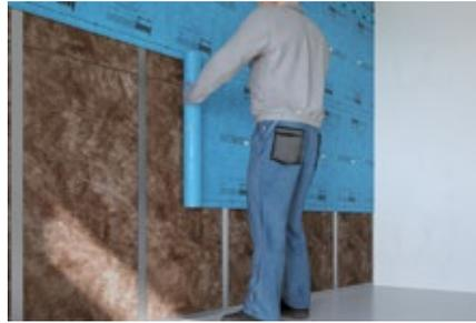
Dann wird die Dampfbremsbahn LDS 2 Silk auf die Konstruktion mittels doppelseitigem Klebeband oder LDS Solifit S fixiert. Anschließend werden die Stoßüberlappungen der LDS 2 Silk mit LDS Solifit S und die Anschlüsse an Boden, Decke und Wänden mit LDS Solimur luftdicht verklebt.
