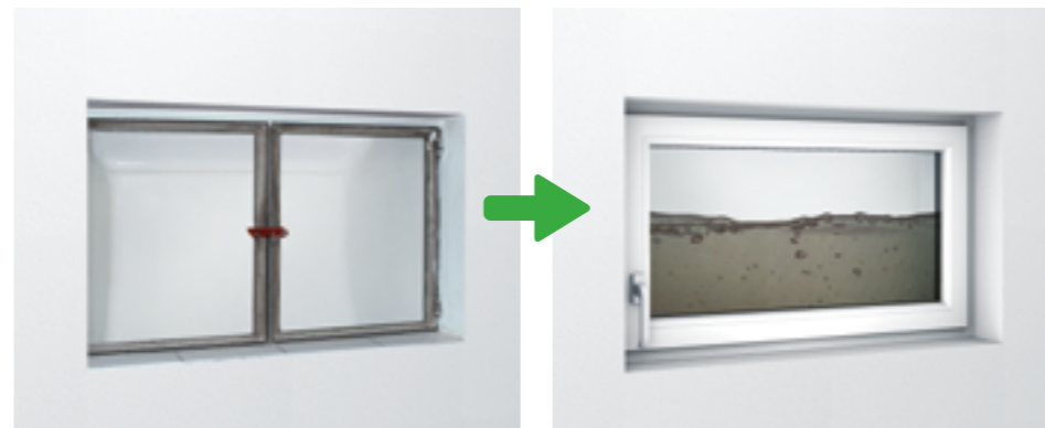
Umbau Stahlfenster mit Glas auf hochwertiges, wasserdichtes Dreh-Kipp-Fenster
